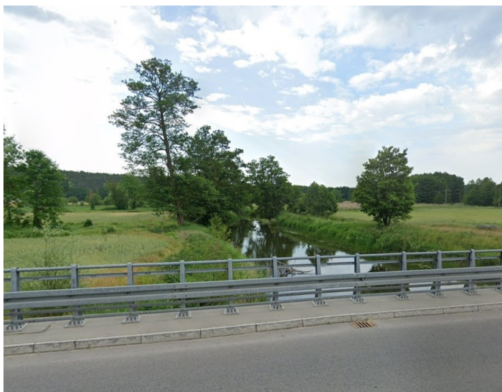
Zdjęcie 3. Widok na rzekę Obrę, Bledzew, ul. Sportowa
