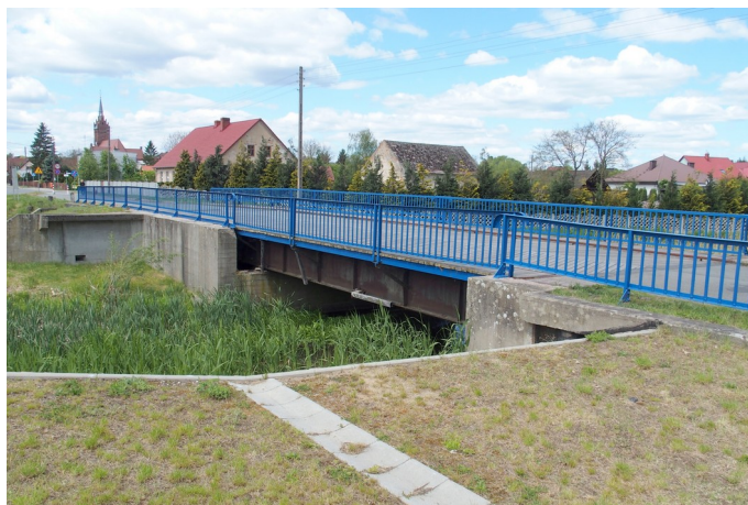
Zdjęcie nr 28. Most przechylno-przesuwny K804 na rzece Obrze w zespole Międzyrzeckiego Rejonu Umocnionego w Bledzewie
