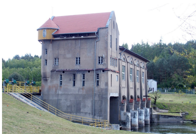
Zdjęcie nr 27. Elektrownia wodna w Bledzewie
