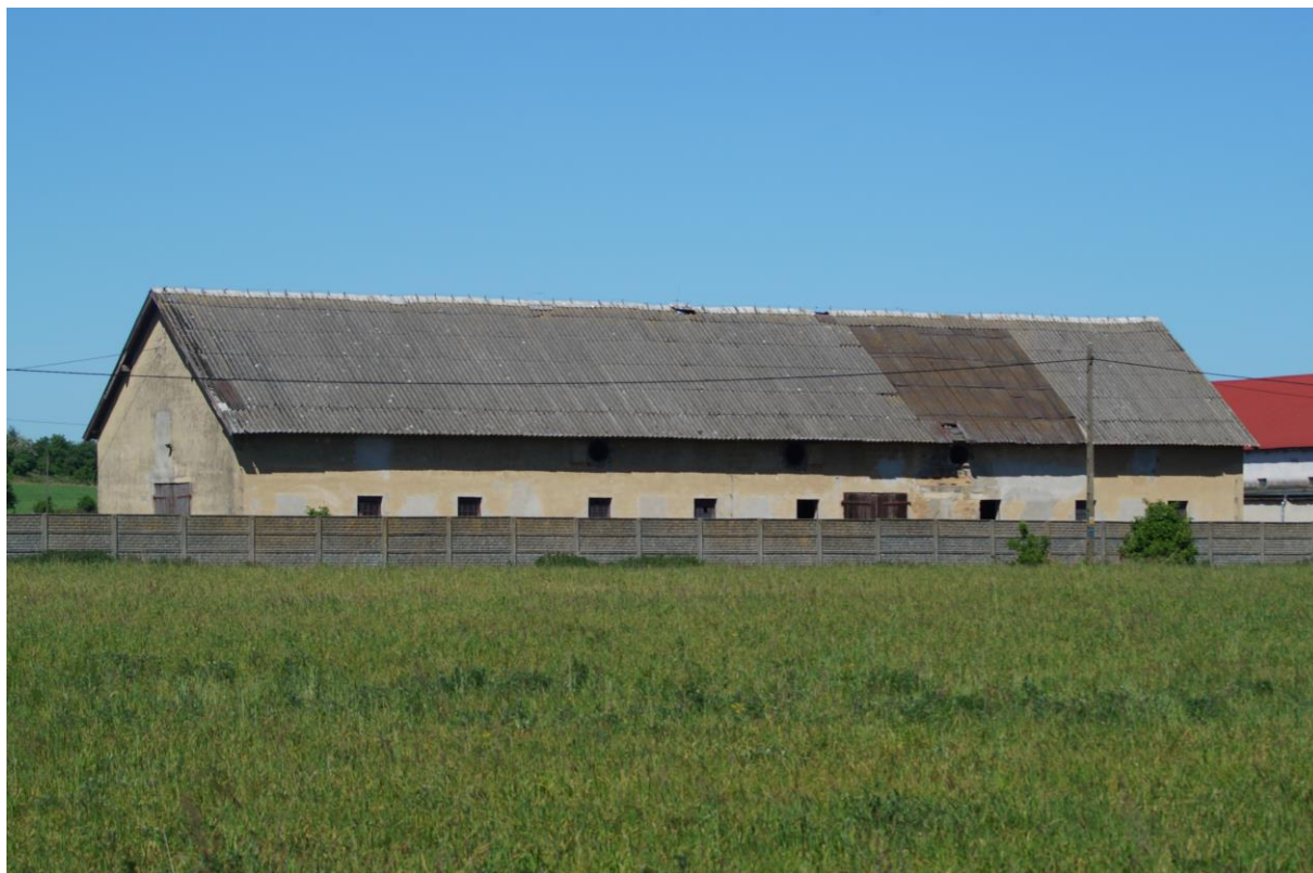
Fot. nr 3 Widok na istniejący obiekt inwentarski przeznaczony do wyburzenia
