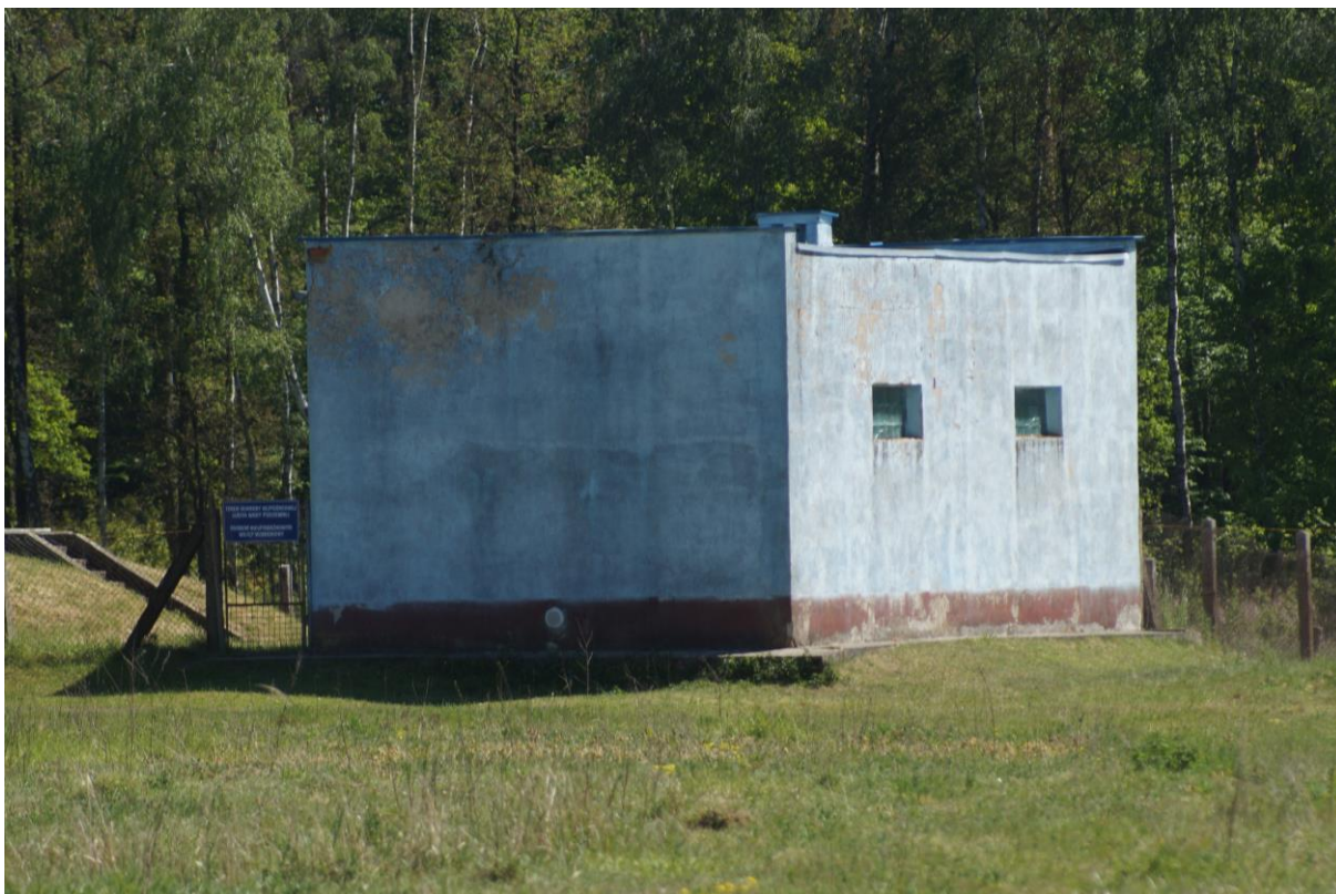
Fot. nr 8 Ujęcie wody podziemnej wraz ze strefą ochrony bezpośredniej na działce nr 440/16 – po południowo-wschodniej stronie istniejących zabudowań inwentarskich fot. Ryszard Kowalczyk
