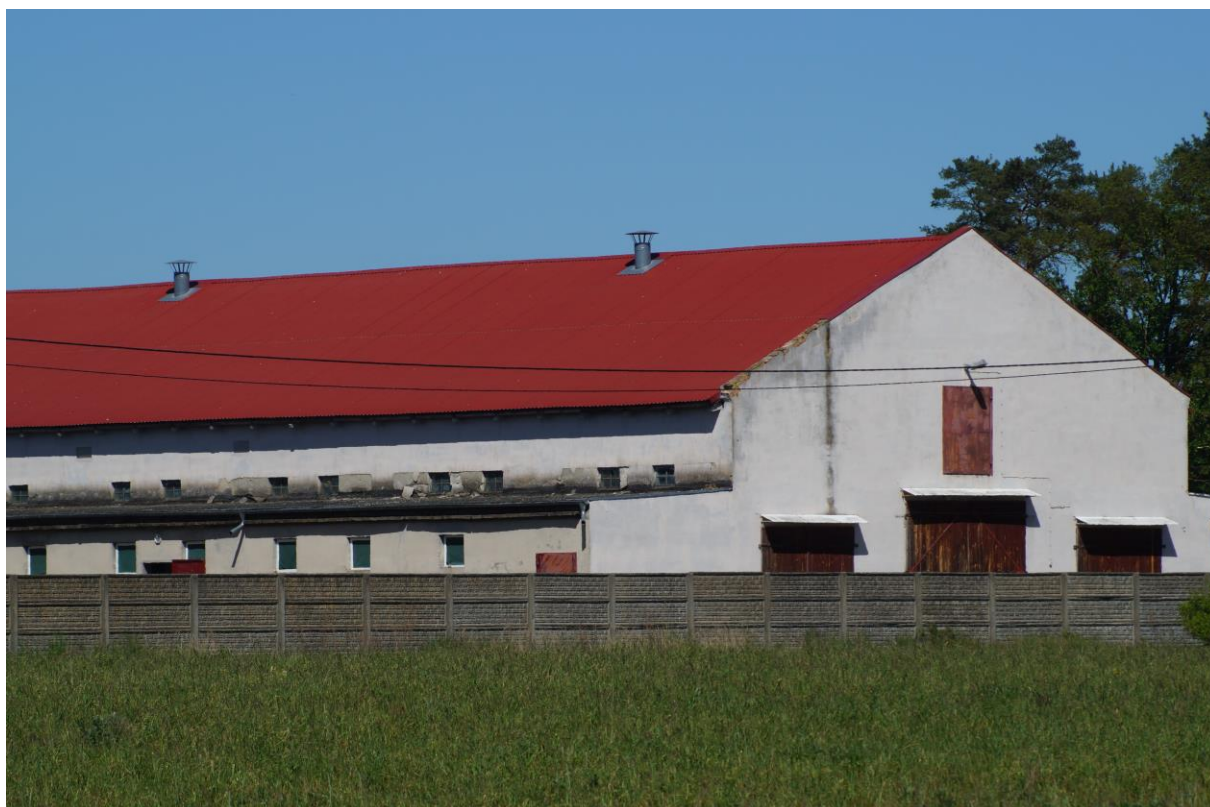
Fot. nr 4 Widok na istniejący obiekt inwentarski przeznaczony do przebudowy i adaptacji na cele chowu indyków
