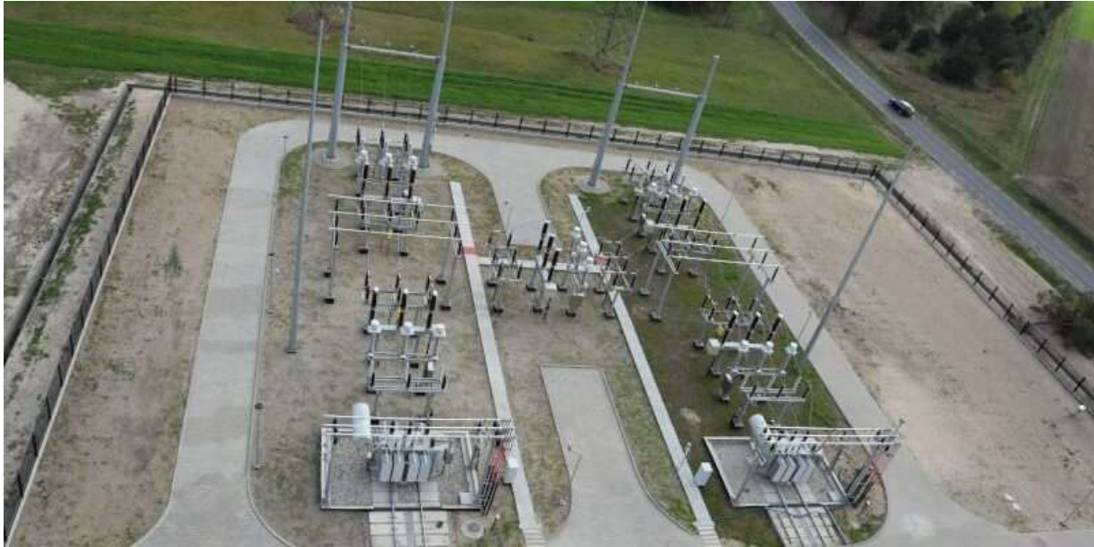
Rysunek 5. Widok obiekt wybudowanej stacji GPZ 110/15kV Stoczek.
