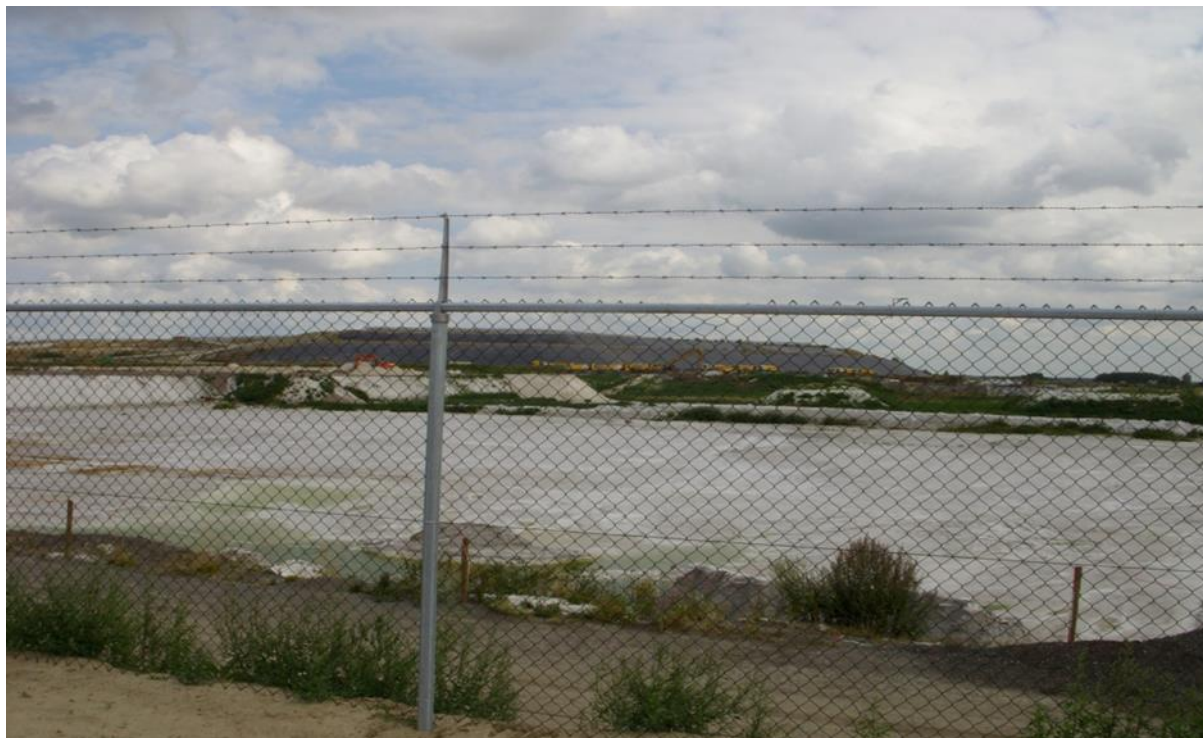
Zdj. 5. Poglądowe zdjęcie obrazujące ogrodzenie
