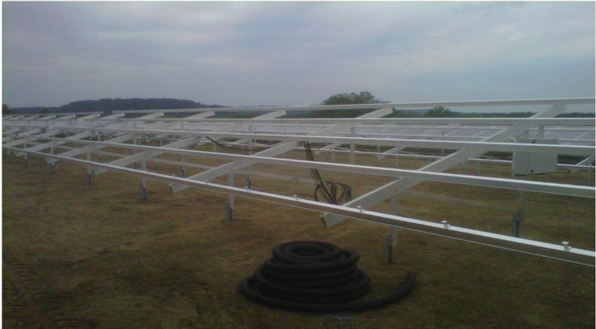
Zdj. 2. Poglądowe zdjęcie obrazujące konstrukcje nośną
